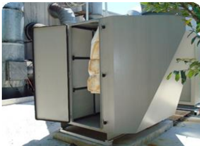
Sistema filtrante installato su impianto a post combustione
