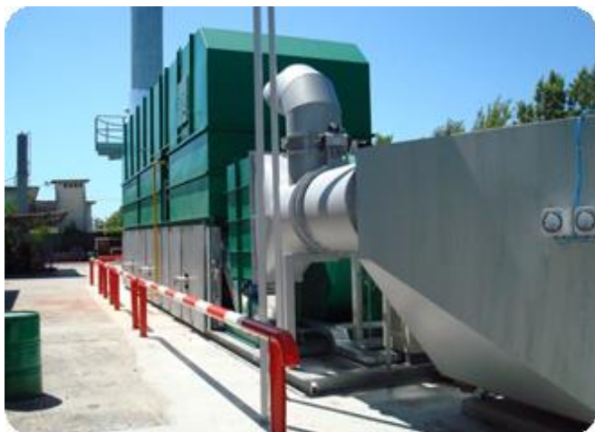
Sistema filtrante installato su impianto a post combustione
